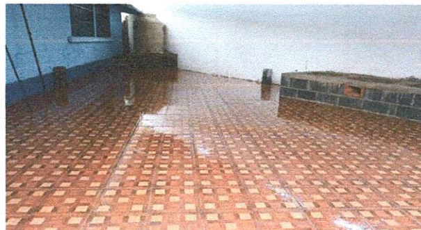
Foto 2: Sustitucion de piso de concreto a piso ceramico
