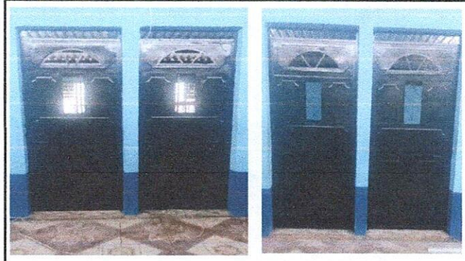
Foto 2: Mantenimiento de puertas de la direccion y tres aulas.
