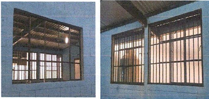
Foto 5: Sustitucion de ventanas de estructura de metal con vidrio de 5mm de 2.00 mts x 1.10 mts
